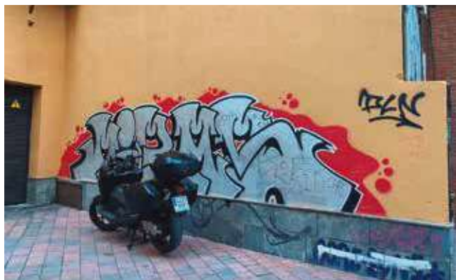
Fachada lateral del colegio Mayor Azarbe antes de su limpieza.
