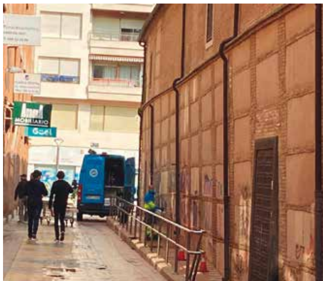
Lateral del centro cultural Las Claras durante los trabajos de limpieza.
