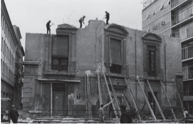
Demolición del palacete del Doctoral de la Riva. 1970.
