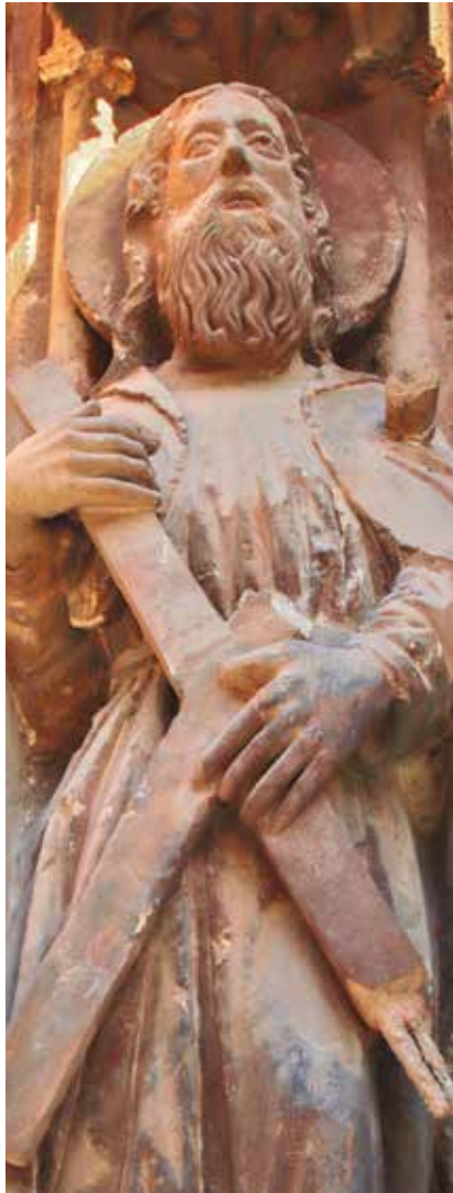
San Andrés y su cruz necesitan una limpieza y una restauración (Puerta de los Apóstoles).
